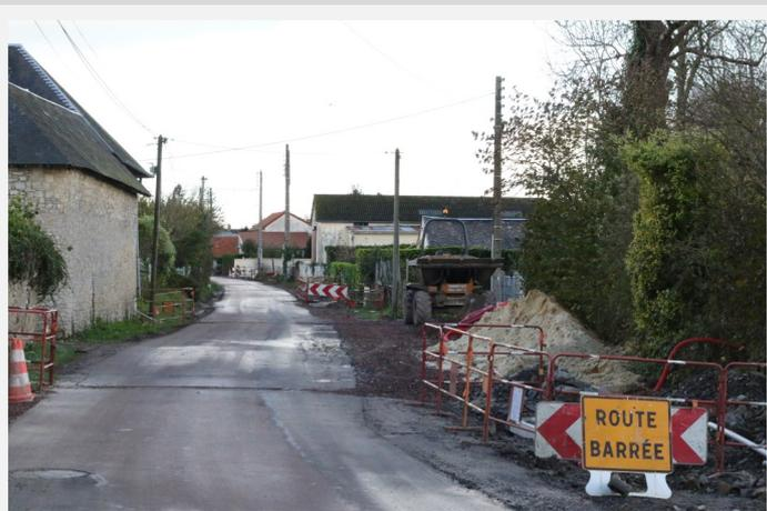
**Les travaux d'effacement des réseaux dans la rue des Vignets** sont en cours, les nouveaux candélabres doivent être mis en place et raccordés pour la fin de l'année.
